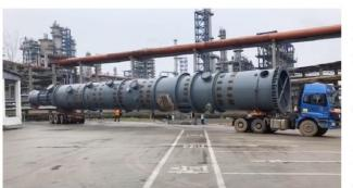
该脱硫塔设备分为上下两段，仅下段设备就长达33米，重达58吨，体积十分庞大，但施工作业场地狭小、固定构筑物障碍多、吊重荷载大等诸多困难，造成设备无法一次性运至施工现场进行“穿衣戴帽”。面对艰巨任务，项目部多次优化倒运方案，提前合理部署，按照方案采用额定荷载分别为220吨和90吨的汽车吊实施双机抬吊作业。
